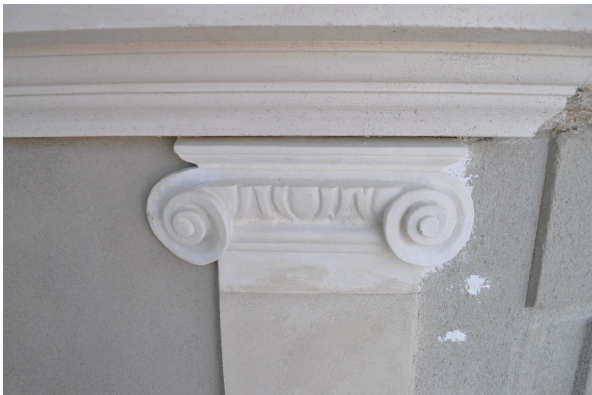
Abb. 7: Vorzustand Ostseite, 1.OG neu gegossenes Kapitell
