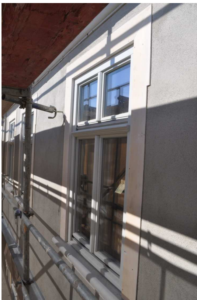
Abb. 10: Detail- Vorzustand Ostseite 2.OG Fensterbekleidung aus Holz
