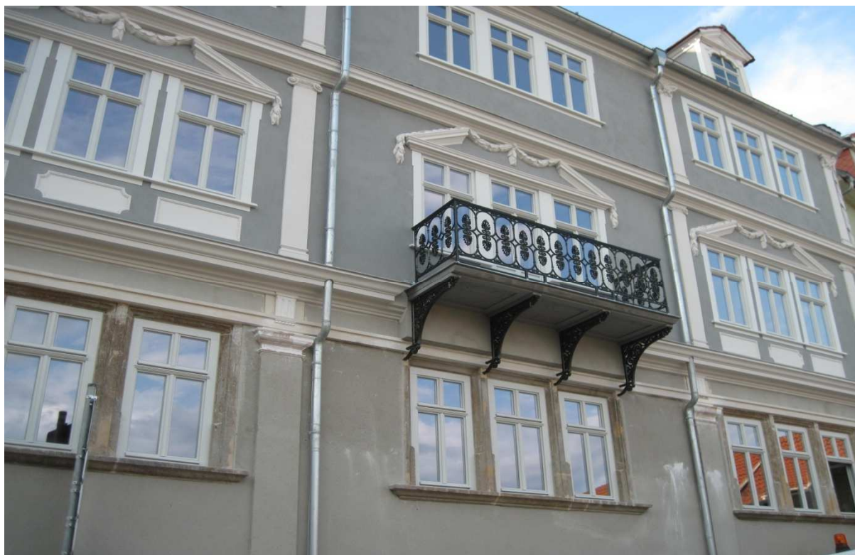
Abb. 11: Nordseite Balkon- Untersicht mit Grundbeschichtung
