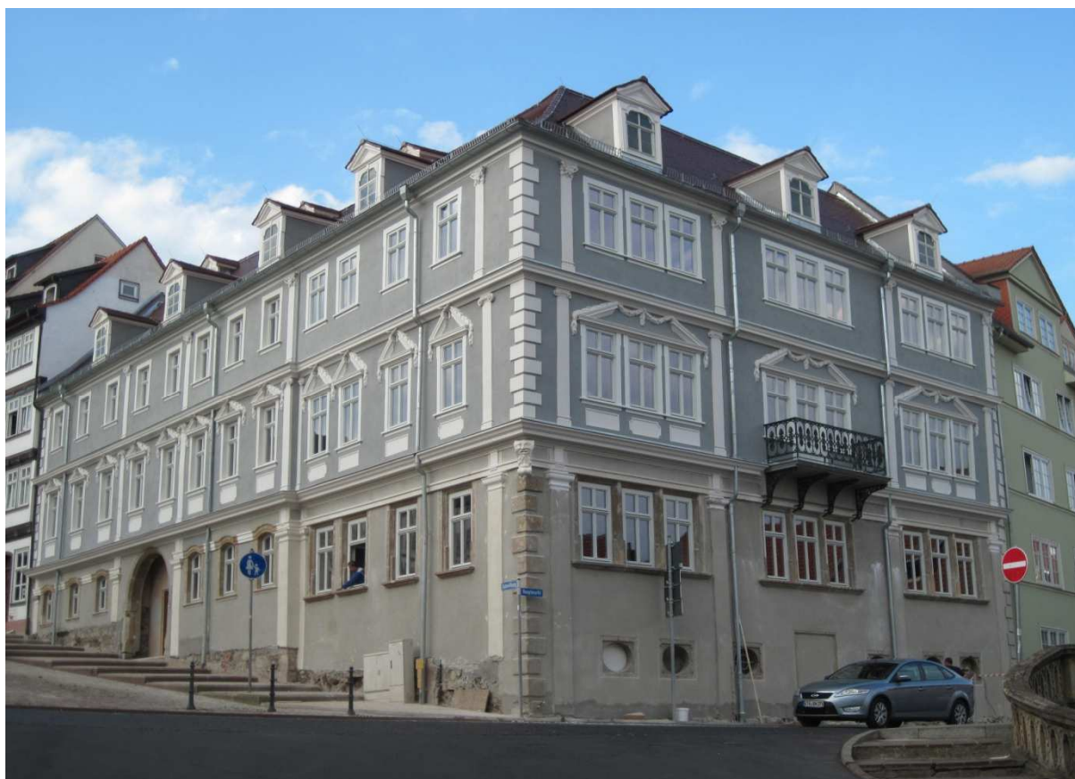
Abb. 12: Gesamtansicht nach temporärem Rückbau Gerüst, EG im Vorzustand ohne Sockel
