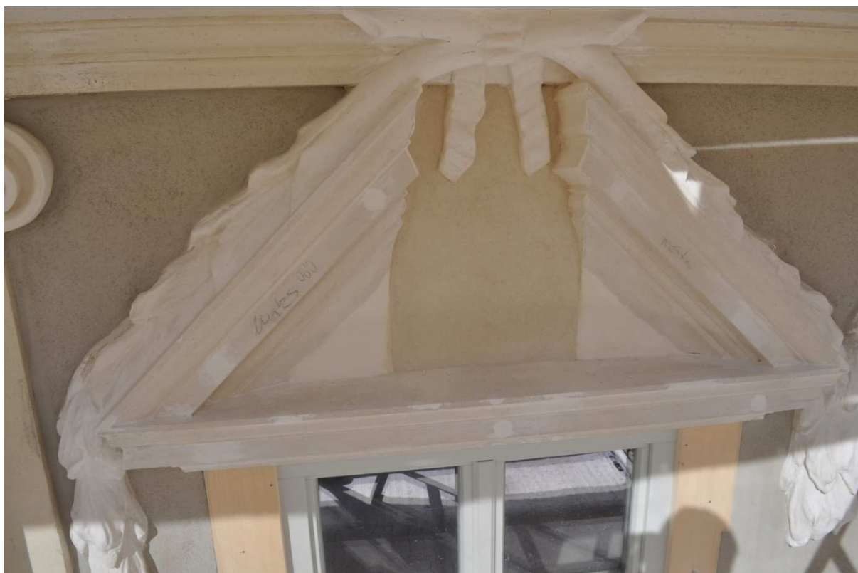
Abb. 6: Vorzustand Ostseite, 1.OG neu versetzte Fensterbekrönung
