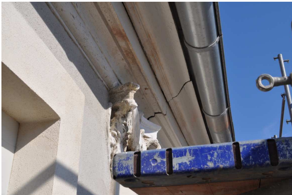
Abb. 9: Detail-Vorzustand Dachkasten Ostseite
