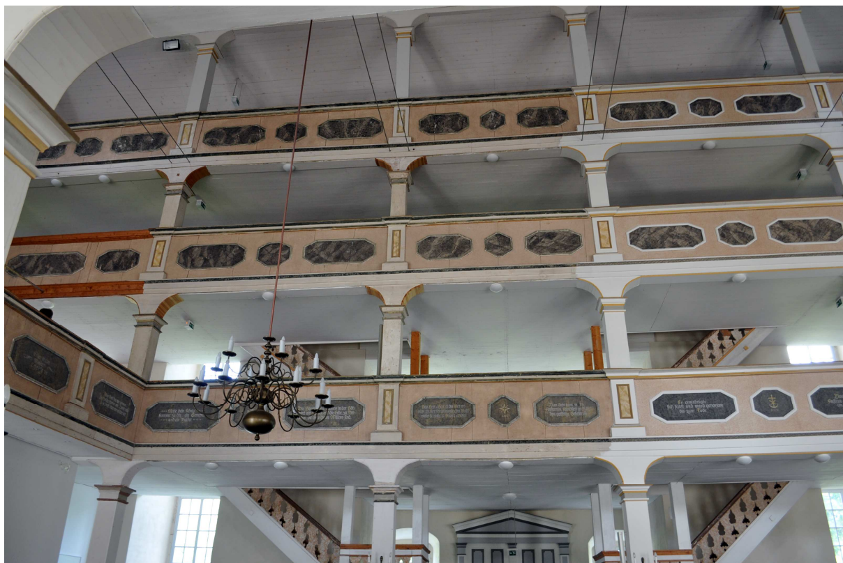
Abb. 7: Vorzustand nördlicher Teil
