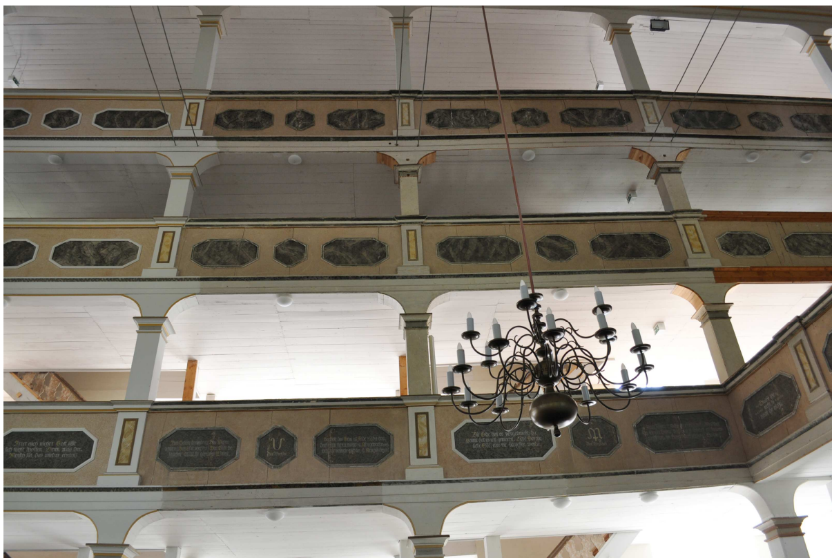
Abb. 3: Vorzustand südlicher Teil
