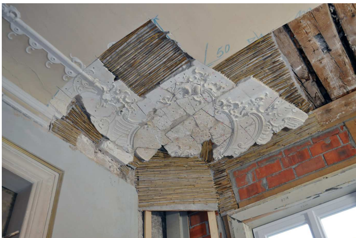
Abb. 16: Vorbereitung der Rücklagen zum Verputz
