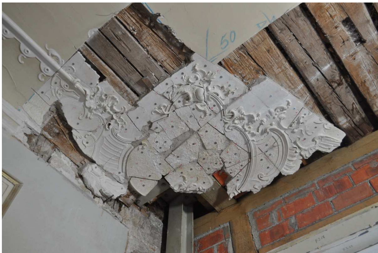
Abb. 15: Versatz der Einzelteile in situ
