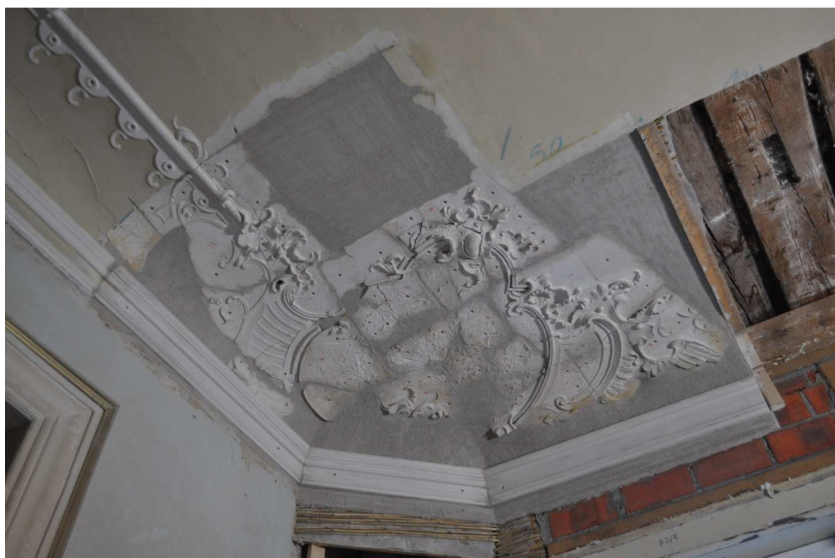
Abb. 18: Versatz der Gesimsprofile
