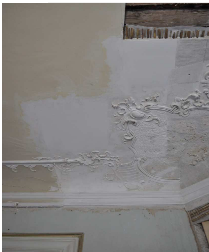
Abb. 20: Detail Endzustand Bereich 2.7/15
