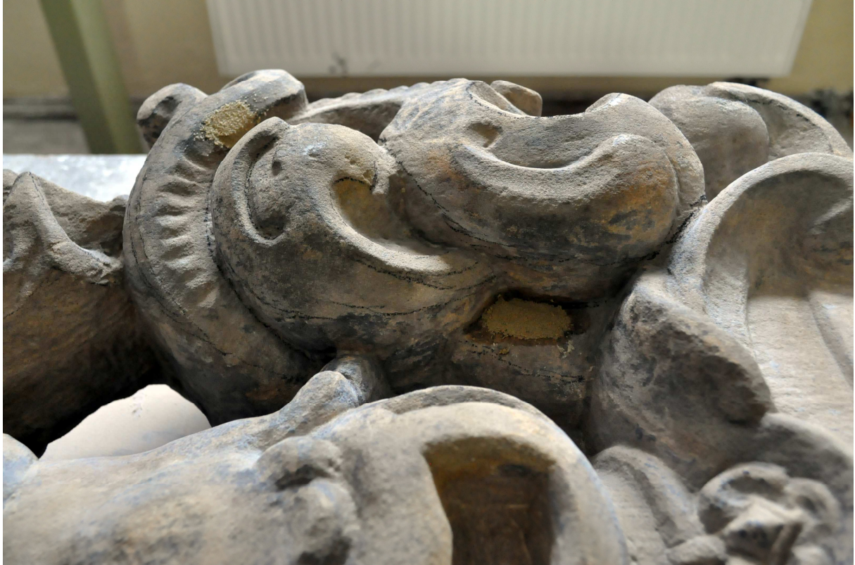
Abb. 4: Zwischenzustand Steingänzungen, Helmdecke
